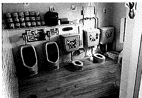
コロナ対応トイレ改修工事
