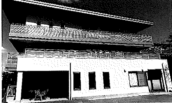
グループホーム内部・外部改装工事
