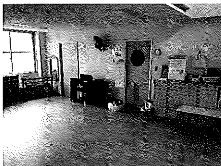
保育室床・壁等改修
