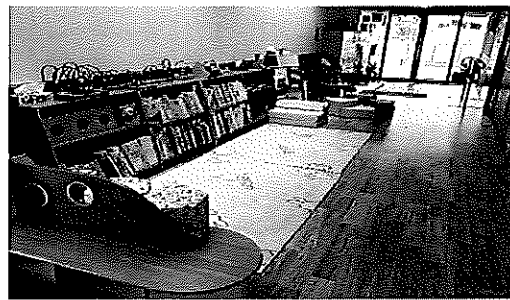
保育園内部床等改修工事
